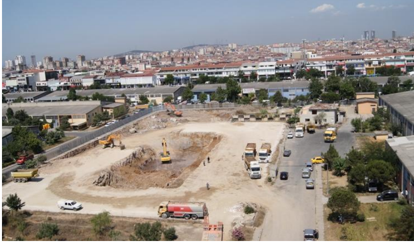
İMES Park Otel ve Metro Alışveriş Merkezi inşaat çalışmaları
