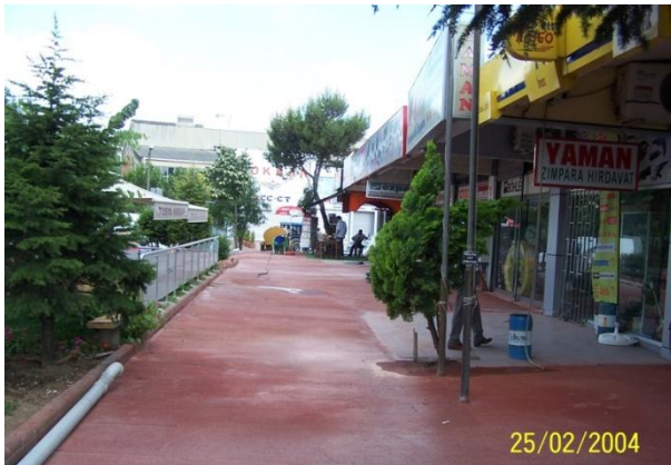
Kırmızı şap betonu dökülme işlemleri.
